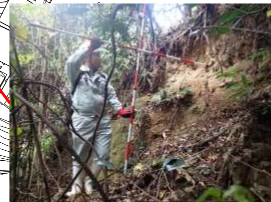
斜面部の表層崩壊跡
