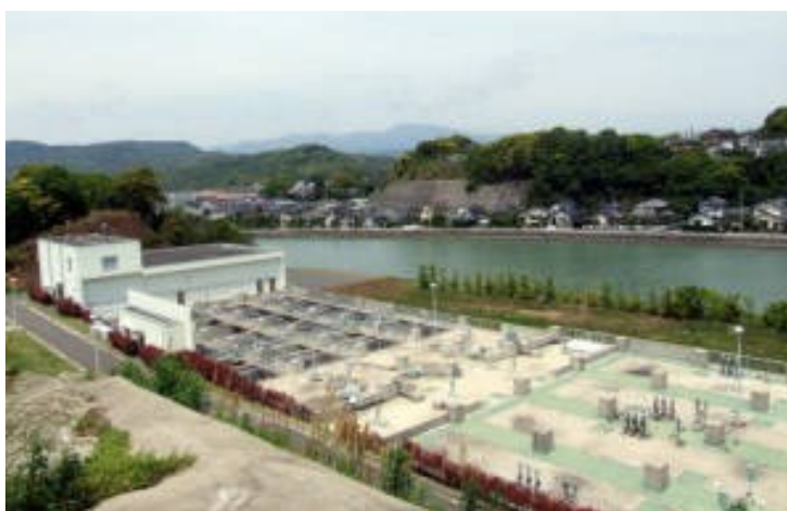
図 5-8 大村湾南部浄化センター水処理施設写真
