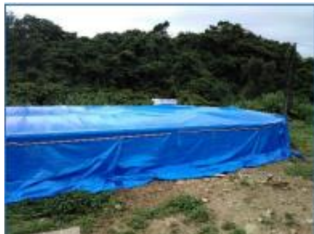
浄化槽の拡散防止対策
