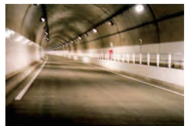
◆トンネル用エコタイル：長崎出島道路
