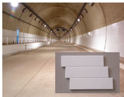
●エコタイル施工例(オランダ坂トンネル)
