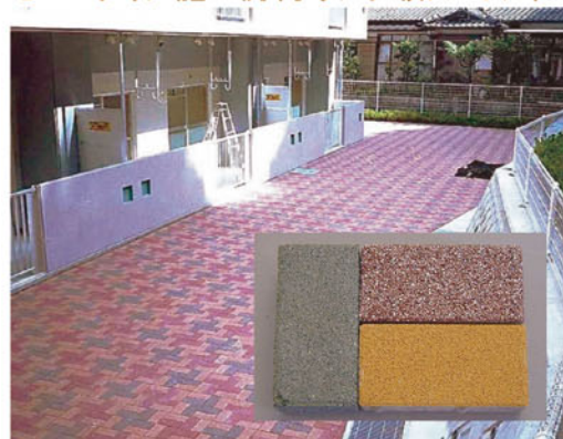
●舗装用ブロック施工例(波佐見町)
