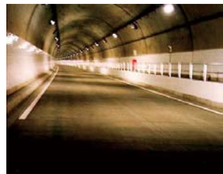
出島バイパスの二丁掛タイル施工写真
