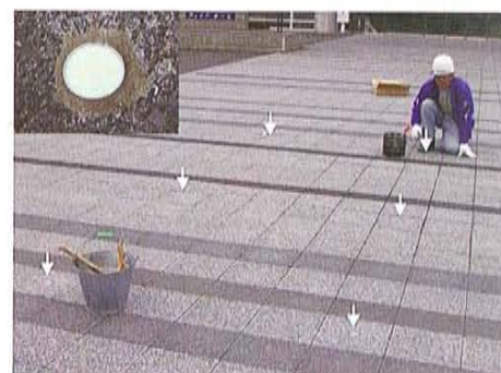
施工の様子と埋め込まれたエコほたる（矢印：施工位置）
