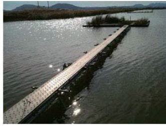
棧橋～(取水)～浮島
