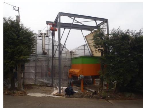
写真1 株式会社製の燃焼装置(左)と燃料サイロ(右)
