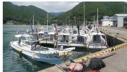
第4種漁港 (荒川漁港:五島市)
