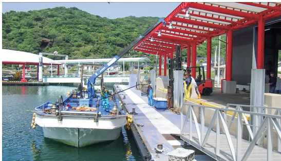
潮位差対策の浮棧橋、防暑対策の屋根
