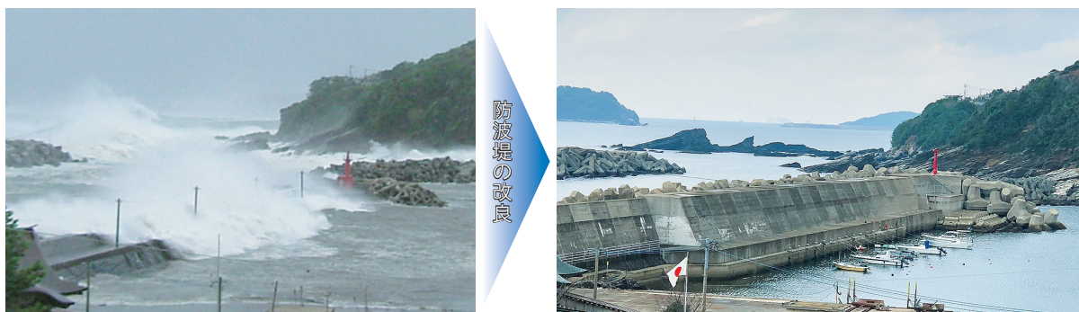
越波被害防止のための防波堤改良
