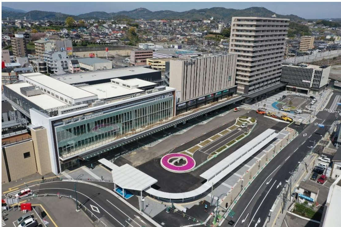
図 1-30 諫早駅東地区第二種市街地再開発事業 完成写真
