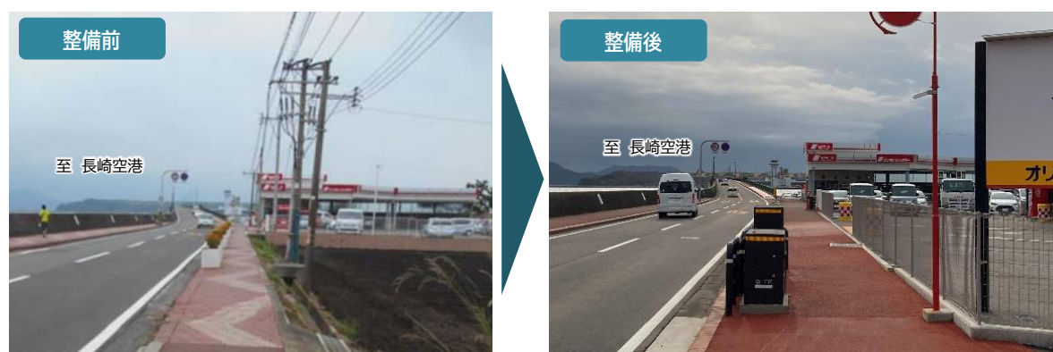
図 6-10 第一次緊急輸送道路における無電柱化
