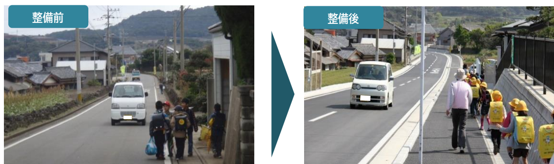
図 6-16 通学路における交通安全対策事例（一般県道大浜福江線 五島市）
