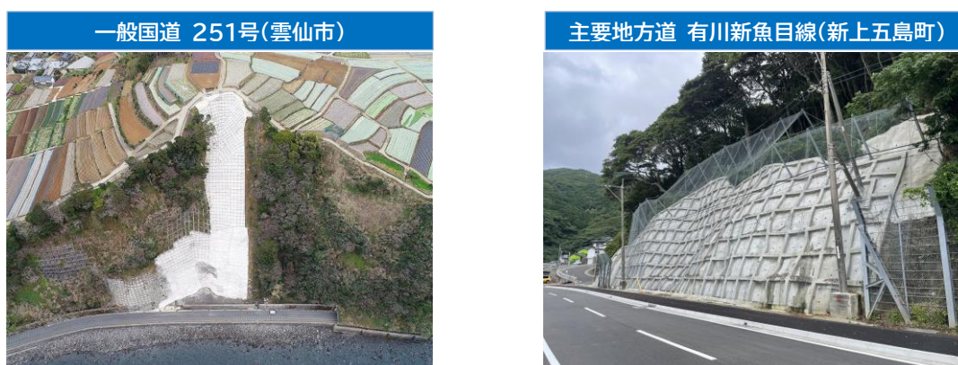
図 6-9 道路法面对策状況
