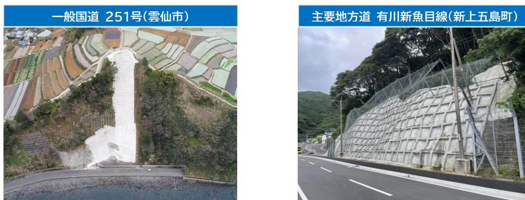
図 6-9 道路法面对策状況
