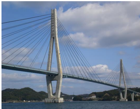
鷹島肥前大橋（松浦市・唐津市）
