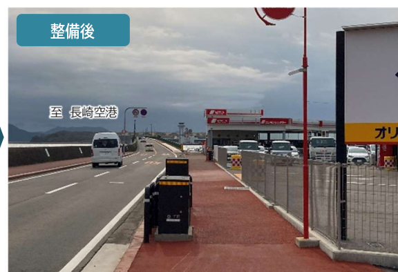
図 6-10 第一次緊急輸送道路における無電柱化
