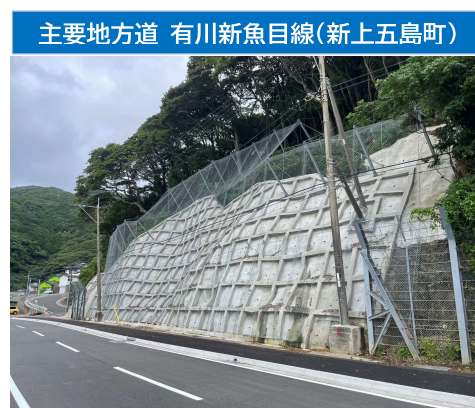
図 6-9 道路法面对策状況
