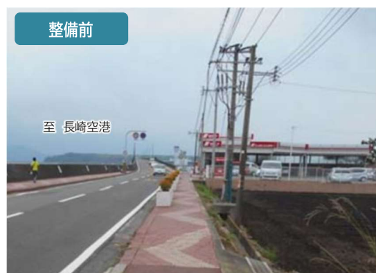
図 6-10 第一次緊急輸送道路における無電柱化
