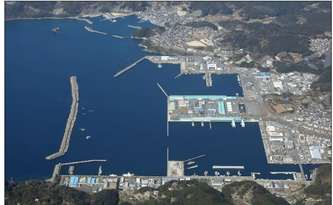
長崎漁港（三重地区）
