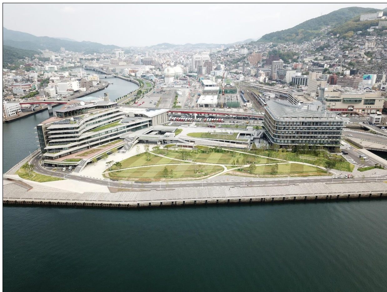
新県庁舎と防災緑地（尾上地区）
