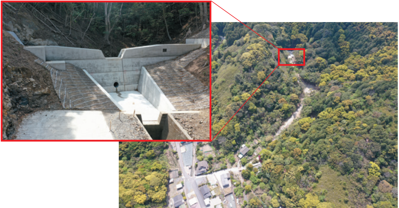
南松浦郡 新上五島町 築地地区（治山事業施工事例）
