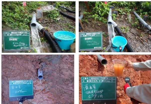
図 15 応急横ボーリング排水状況
