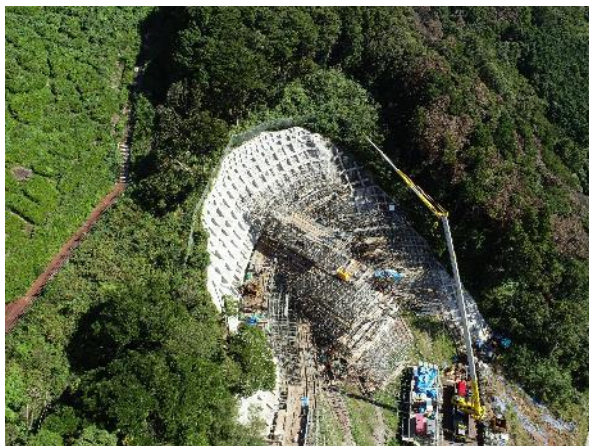
図18 法面对策工施工状況 (2024年(令和6年)11月)
