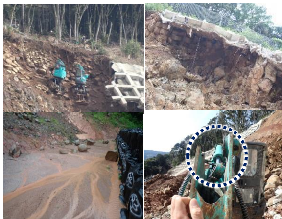
図12 崩壊斜面掘削状況
