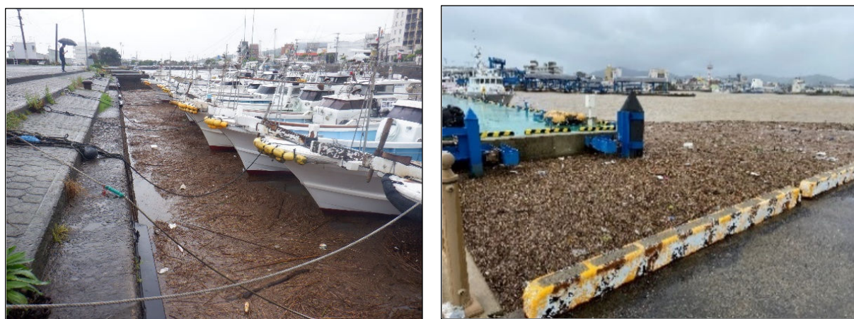
図-2 埋塞時の港内状況（福江港）
