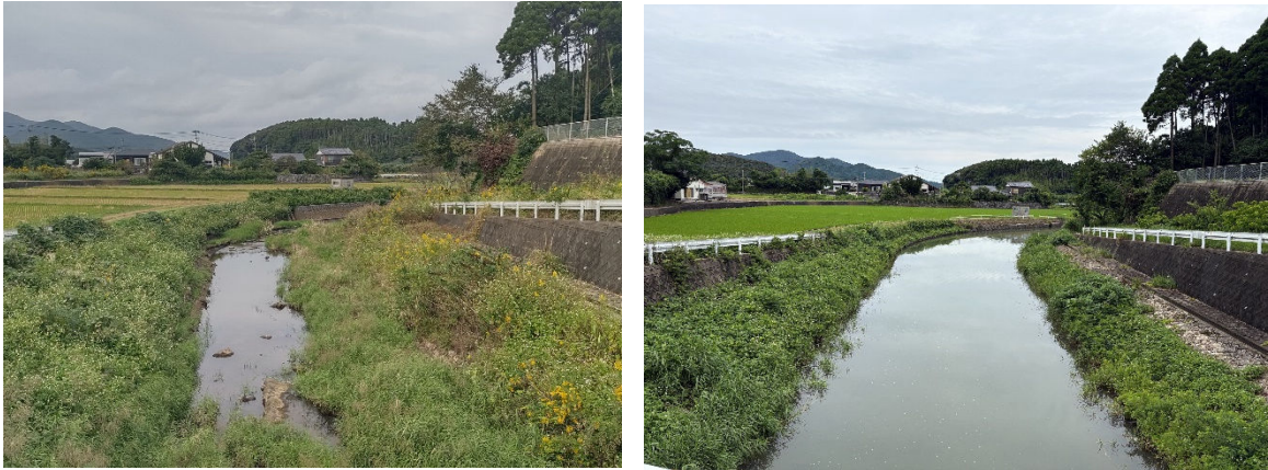
図-4 令和8年4～7月の牟田川の伐採状況（左：伐採前、右：伐採後）
