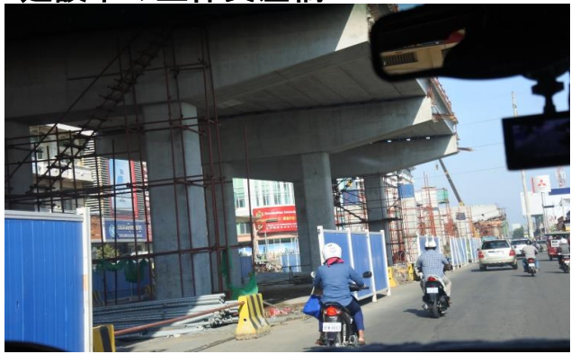
建設中の立体交差橋
