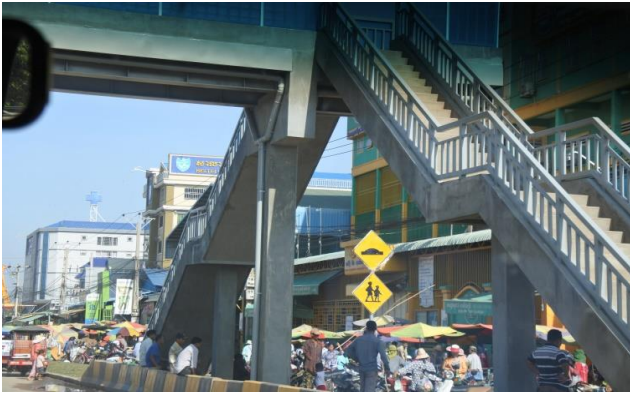
建設中の初の歩道橋
