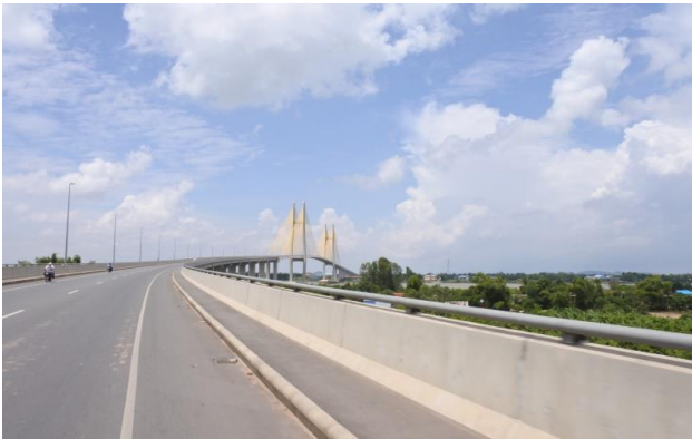
ODAで架けられた ネアックルン橋梁(つばさ橋)
