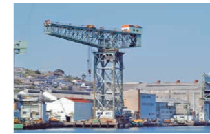
●미쓰비시 나가사키 조선소 지이엔트 캔틸레버 크레인
