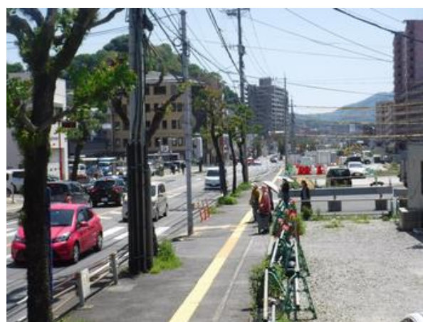
大神宮工区の現況 (大神宮交差点付近の拡幅予定地の状況)
