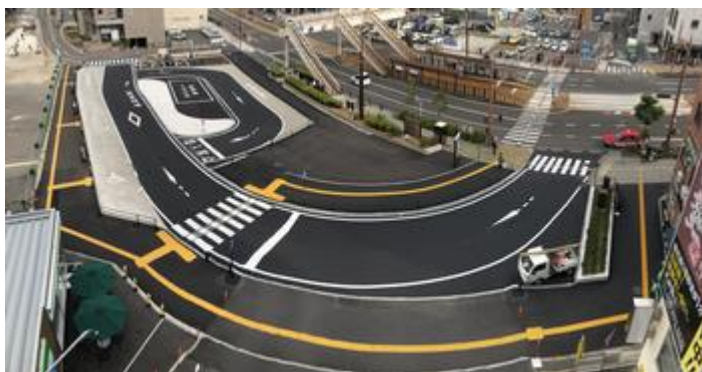
浦上駅前広場の供用状況
