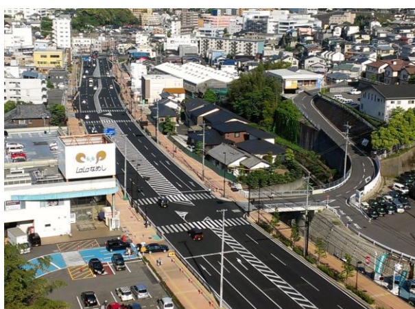
横道工区の供用状況
