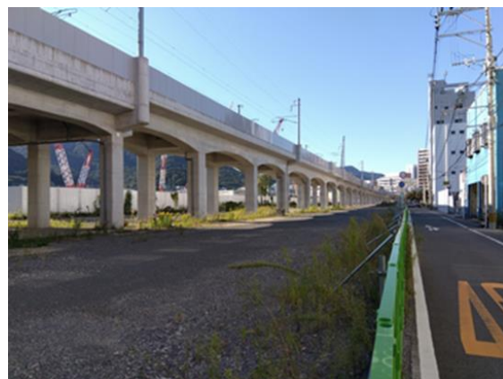
長崎駅東通り線の現況
