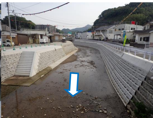
整備区間(完成)
