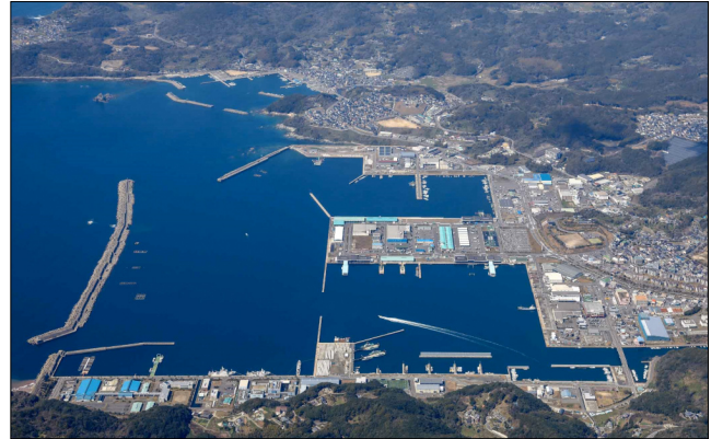
長崎漁港（三重地区）
