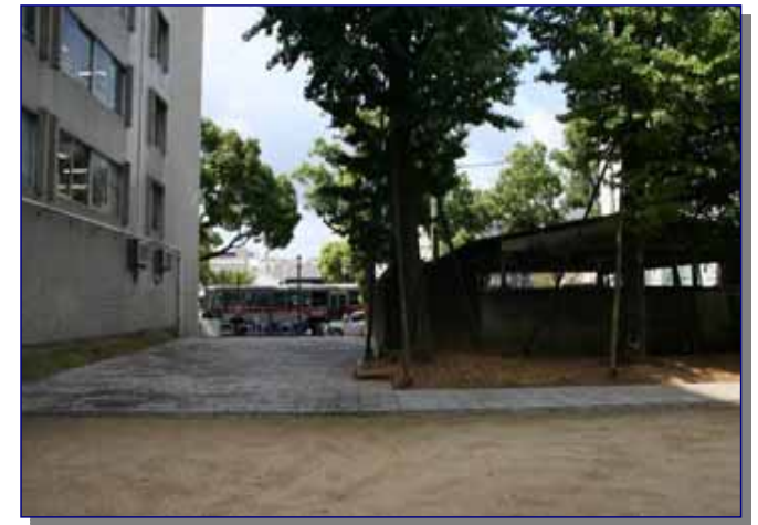
第一別館と第二別館車庫
