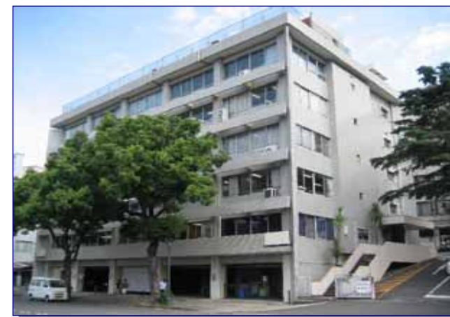
第一別館(昭和42年建設)
