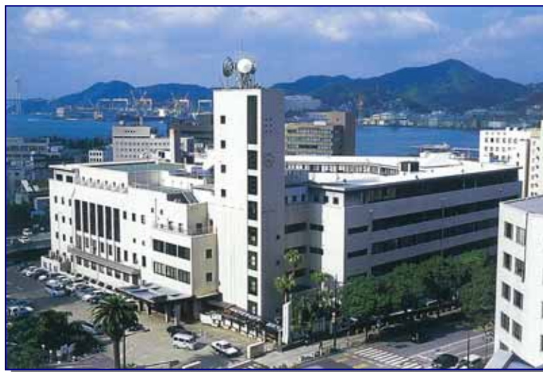
本館(昭和28年建設)
