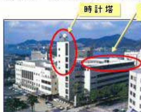
県庁舎の耐震改修困難箇所
