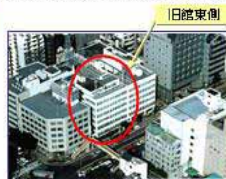
警察本部庁舎の耐震改修困難箇所
