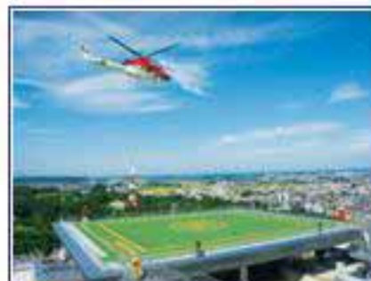
屋上ヘリポート (栃木県)
