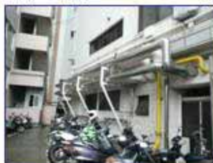
屋外に露出した配管
