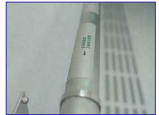
点字シール付手すり (鹿児島県)
