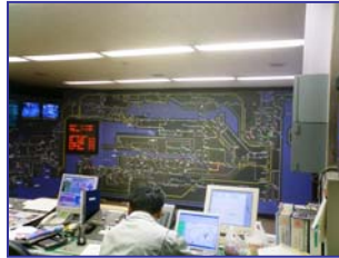
交通管制センター (十分なスペースが確保されていない各施設)
