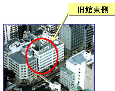
警察本部庁舎の耐震改修困難箇所
