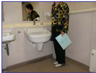
オストメイト用トイレ (熊本県)
