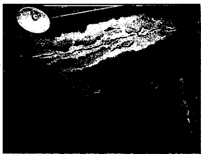
時計塔内天井のひび割れ
