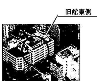
警察本部庁舎の耐震改修困難箇所
