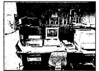
空調管理室 (空調設備のみの管理)
