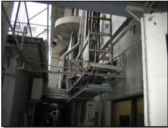
屋外に露出した配線
