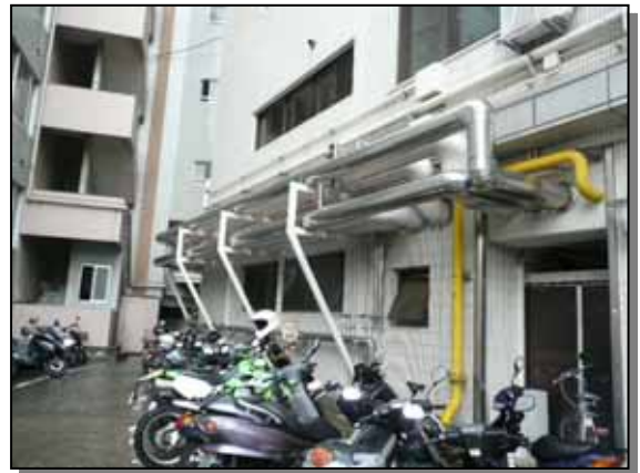
屋外に露出した配管
