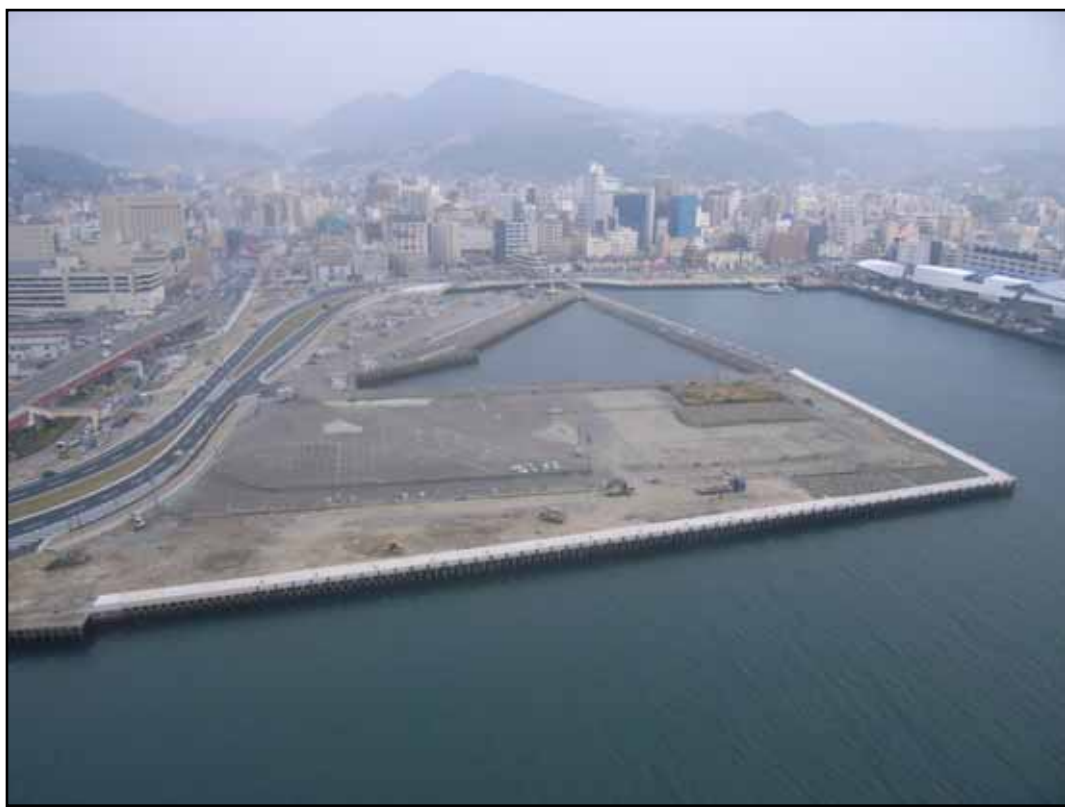
埋立工事が進む県庁舎建設予定地
