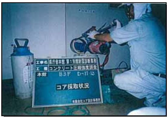
コンクリートコア抜き
