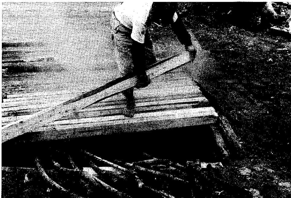
写真2 燗付け温泉埋設作業 (昭和55年7月)
