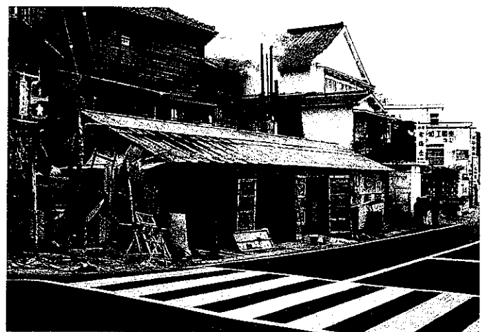
トタン小屋左手の壊れた所から噴出した。
