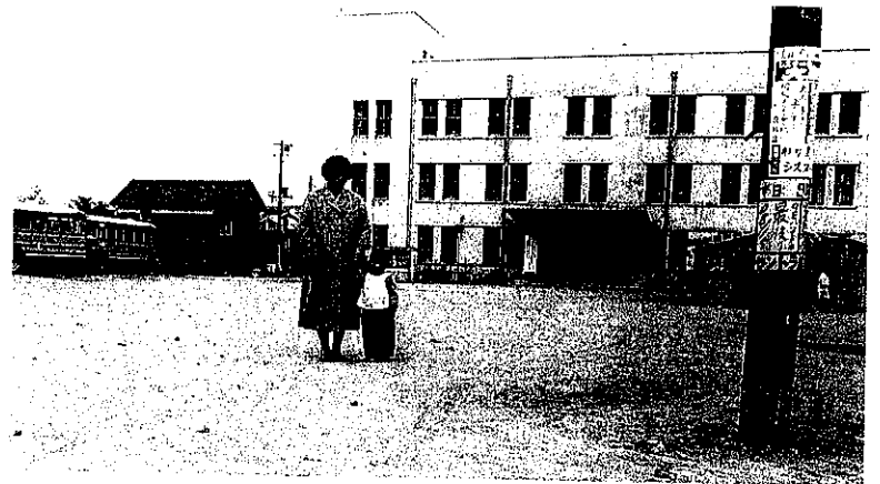
写真25 市役所と大手広場
