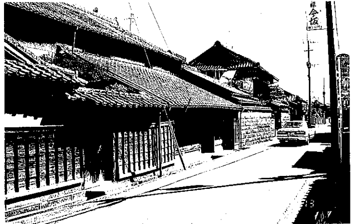
時代の面影を残している白土町の旧道の家並み（1991年3月）
