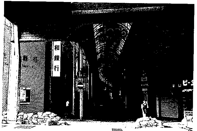
写真31 さびしくなったアーケード街
