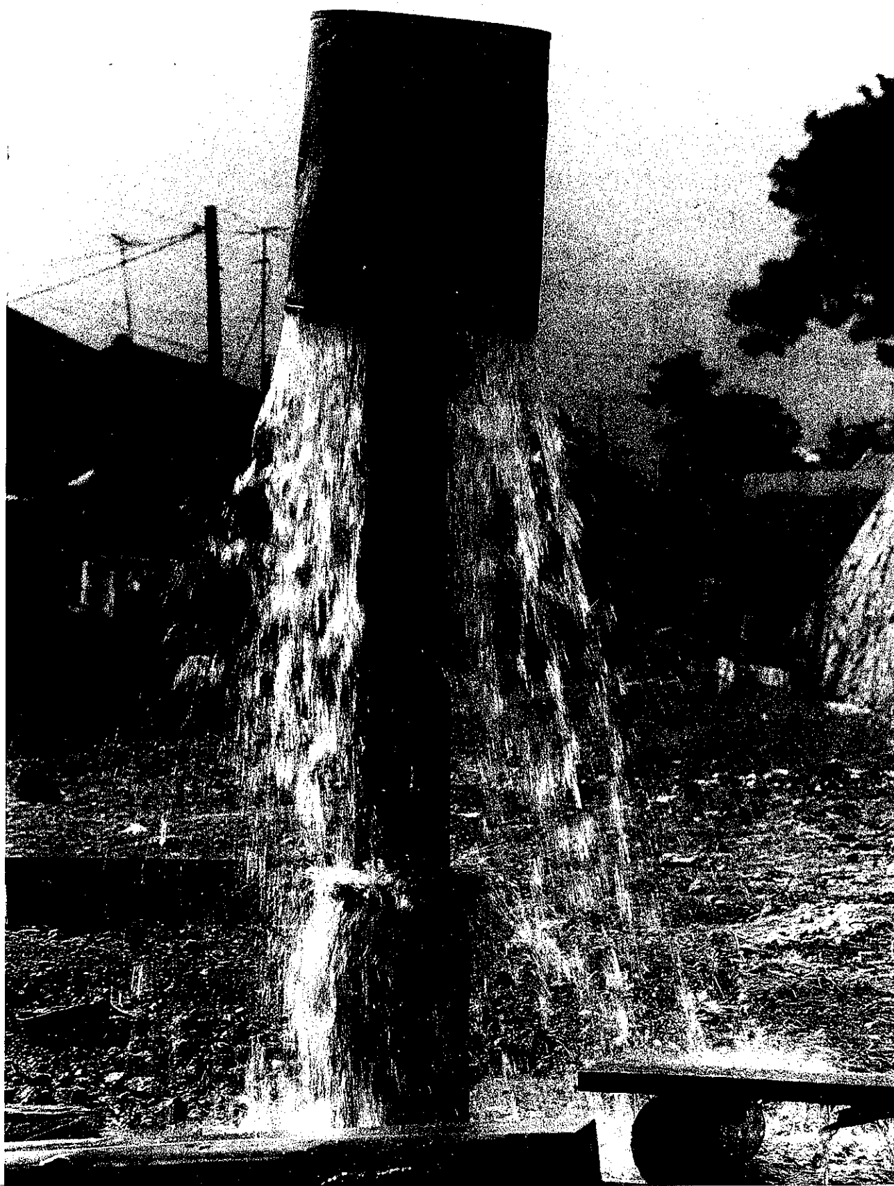
1967年（昭和42年）8月7日に深さ185mで31.5℃の温泉水が自噴し、湧出量2000トン／日と推定
