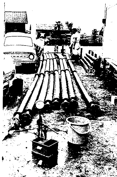
給湯管（フジパイプ）の水圧試験中
