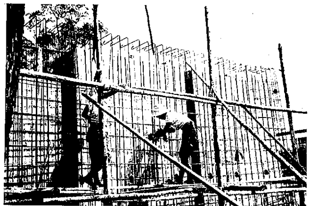
貯湯槽の外壁鉄筋工事
