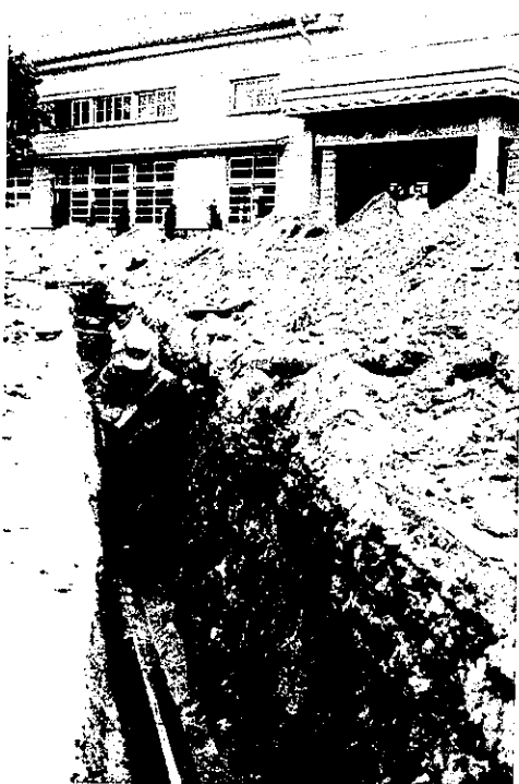
南島原駅前への布設。温泉用のフジパイプ直 径125mm。
