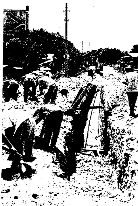
左上は簡保センター、ここでは配管は送り と戻りの2条を布設中。
