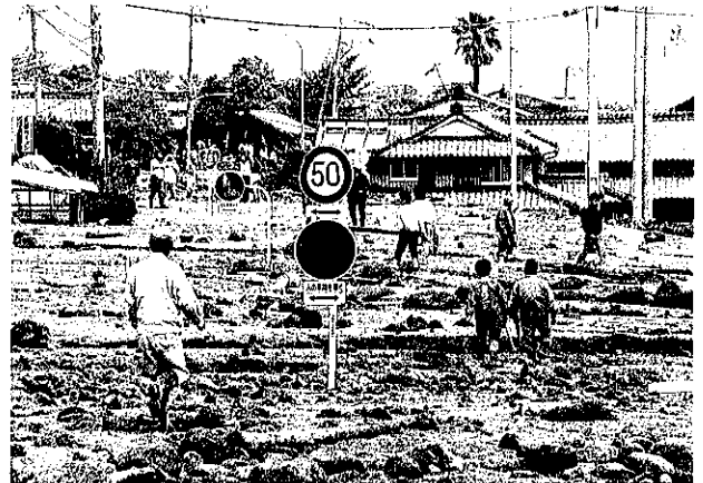
国道251号水無川橋近く。埋まった標識が低く見える。
