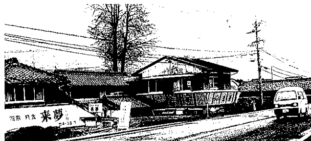
写真20 1階の庇まで高くなった国道251号
