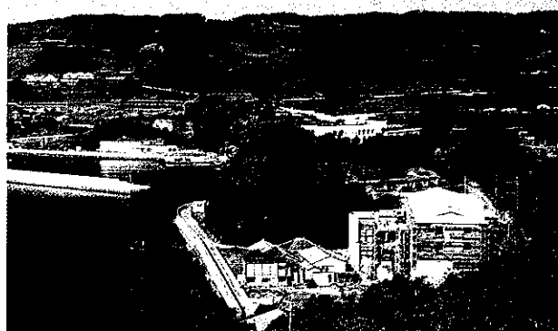
建設中の湯庵ひらやま (ユートピアランド平山)
