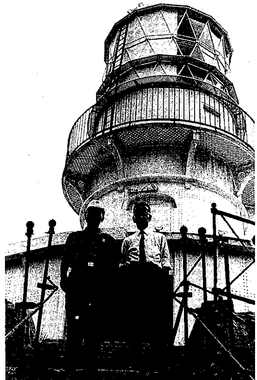
写真89 大瀬崎灯台、1969年（昭和44年）8月頃
