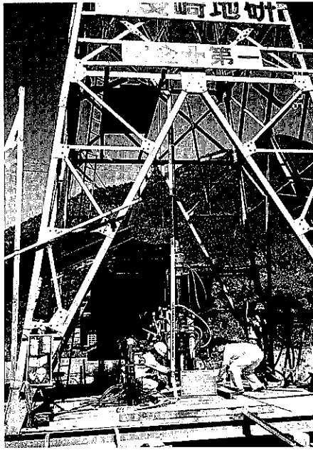
写真55 温泉掘削作業中（深さ432m，1990年8月29日）
