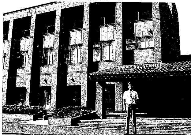
写真124 奈良尾温泉センター
