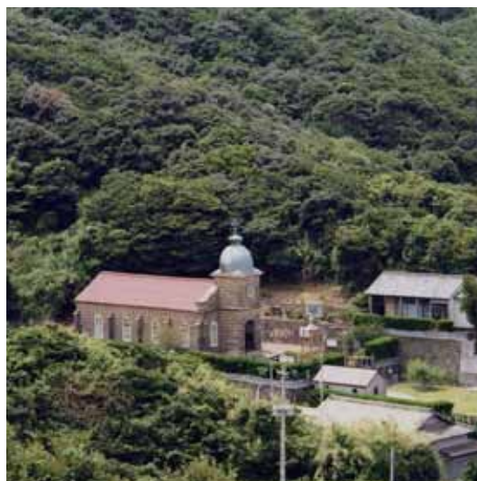
新上五島町崎浦の五島石集落景観（頭ヶ島天主堂）
