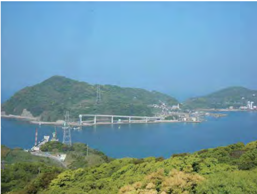
一般県道伊王島香焼線（伊王島大橋）
