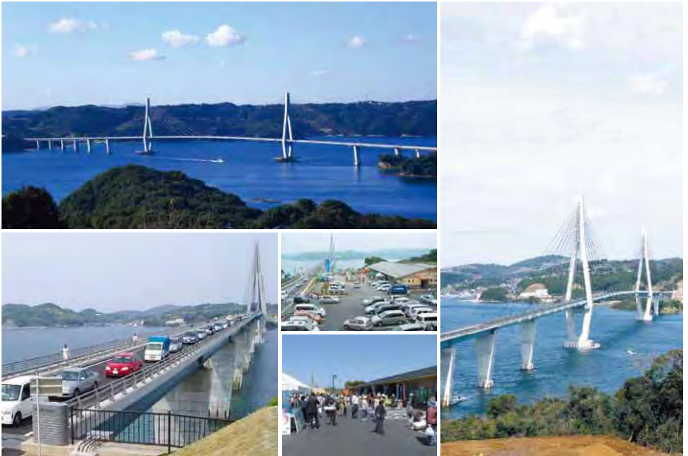
鷹島肥前大橋（平成21年4月開通）
