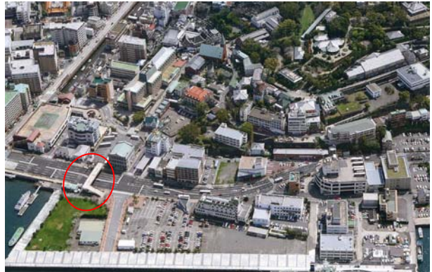
松が枝暫定歩道橋の撤去
