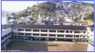
太陽光パネルによる発電事例（桜町小学校）
