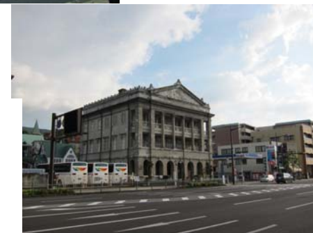
写真〈松が枝歩道橋撤去前後〉
