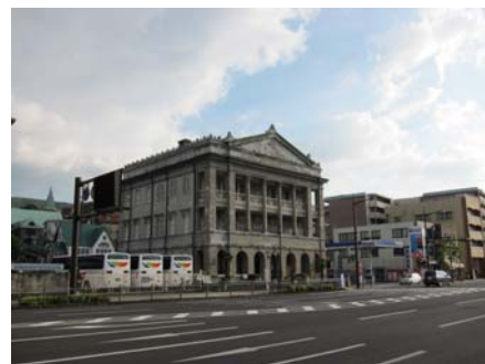
写真-5 〈旧香港上海銀行長崎支店記念館前〉 歩道橋が撤去された後
