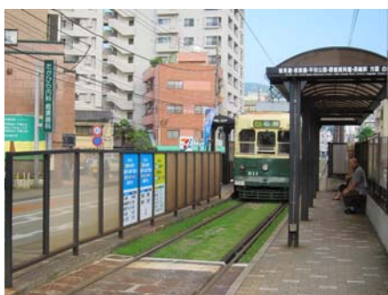
写真-15 路面電車の軌道敷の緑化 〈大浦天主堂下電停〉
