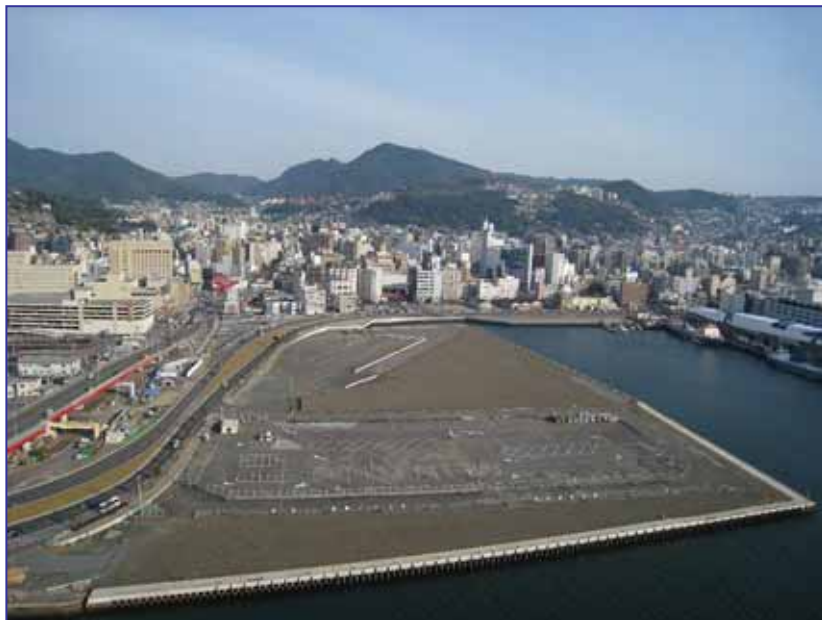
県庁舎建設予定地(長崎魚市跡地)の現況写真
