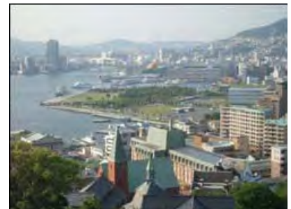
写真-14 〈長崎港内港地区全景〉
