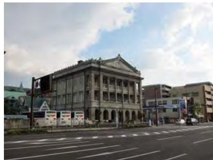
写真-5 〈旧香港上海銀行長崎支店記念館前〉 歩道橋が撤去された後
