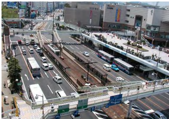
写真-10＜国道202号(長崎駅前電停)の現状＞
