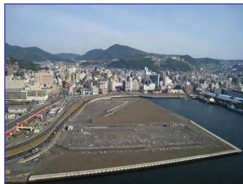
写真-12 県庁舎建設予定地（長崎魚市跡地）
