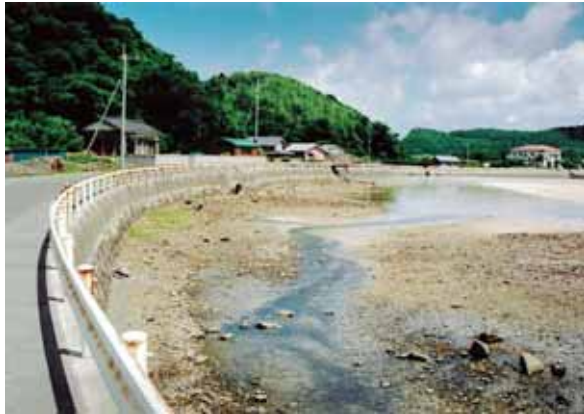
整備実施前全景
