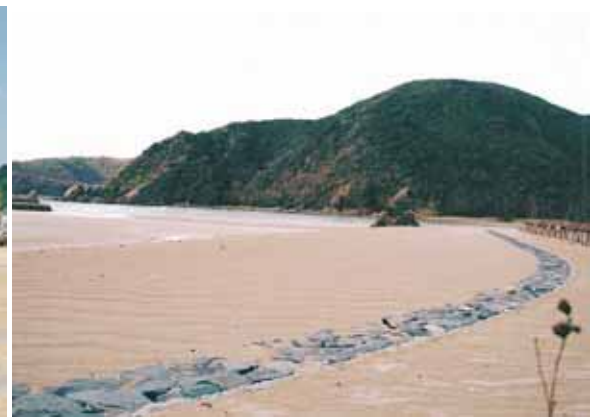
養浜施工箇所
