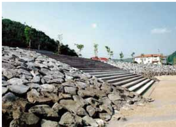
石張式護岸と階段工
