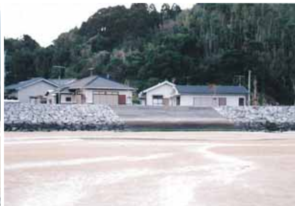
階段工施工箇所
